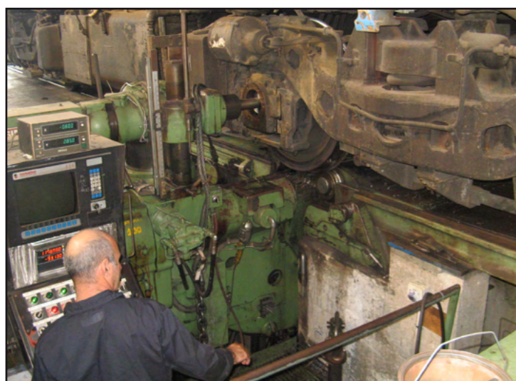
Обработка на подрельсовом станке для восстановления профиля колес локомотива без их снятия.
